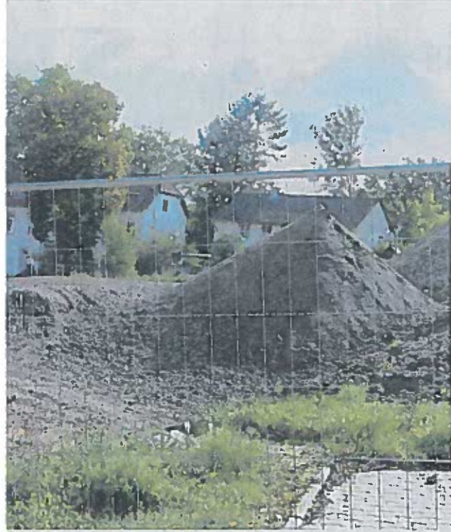
Abriss der Gebäude begonnen. Die Arbeiten gingen voran. Innerhalb kurzer Zeit waren Baumaterialien zerkleinert und ist seither auf dem Gelände gelagert. Seit Wochen
